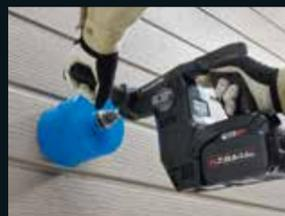
Perforación del panel de revestimiento con sierra con orificio central ( $\varnothing 160 \times 16\text{mm}$ )
