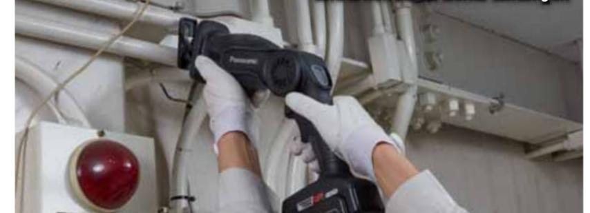
Schneiden eines PVC-Rohrs vor Ort
