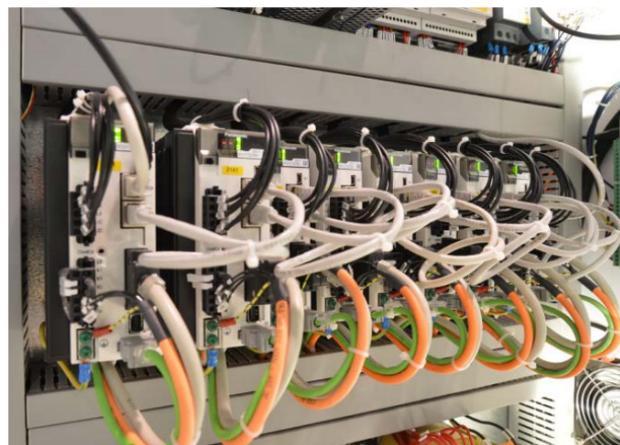
prevedono l'integrazione di tanti dispositivi. Per questa ragione la scelta di utilizzare CoE sul servozionamento A6B (CanOpen Over EtherCat) garantisce, infatti, l'utilizzo degli stessi meccanismi di comunicazione del protocollo CanOpen Standard EN 50325-4, cioè Object Dictionary, Mappatura PDO e SDO.
